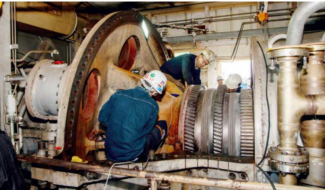
El equipo de la Central Oscar Smith, culminó durante el mes de octubre el mantenimiento programado (MAPRO) previsto para la unidad de generación Turbo Gas 18 (modelo 6FA.03 General Electric) considerado estacional y autorizado por CAMMESA.
